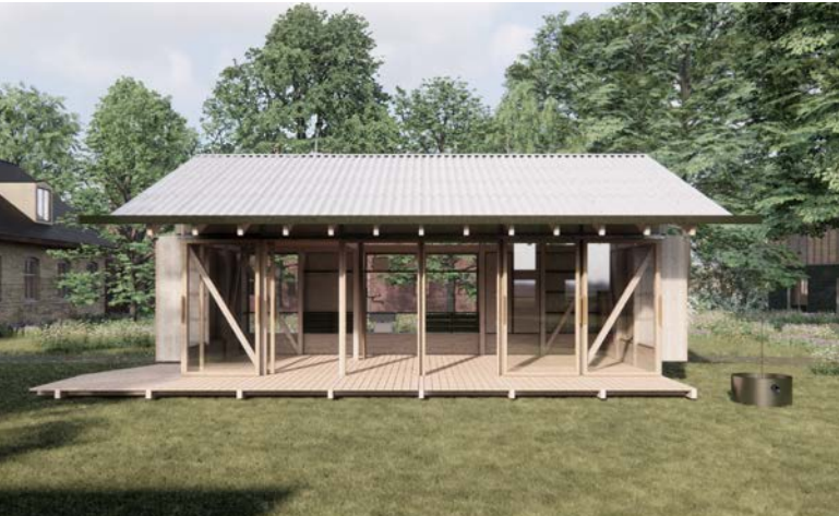
Værkstedet forfra. Transparent facadebeklædning, indgang og skydedøre.
