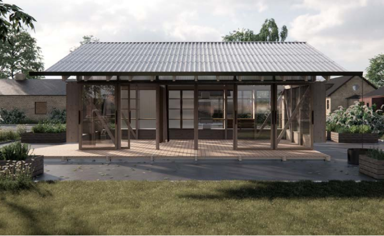
Udestuen forfra. Transparent facadebeklædning, indgang og skydedøre.
