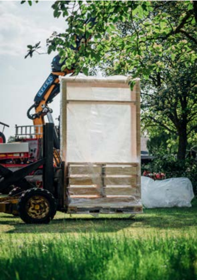
Facadeelementerne pakkes på paller og monteres på konstruktionen element for element.
