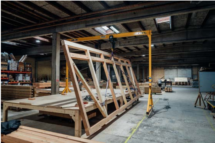
Elementerne samles på borde og rejses først, når de er færdige og skal til pakning. Her en facade.
